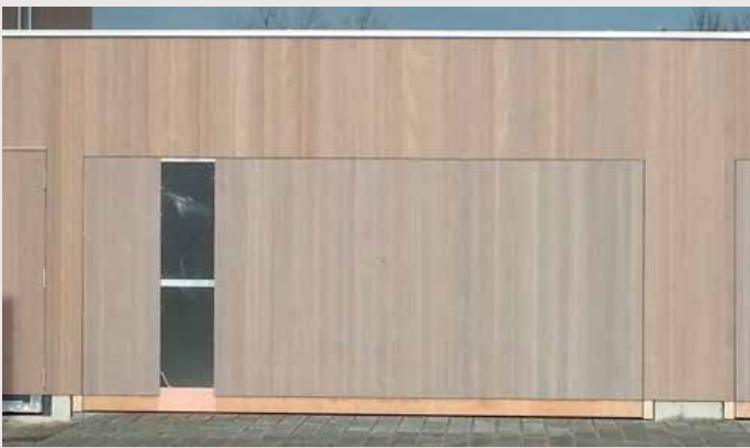
► Garagentor nach zwei Monaten eingesetzt.
